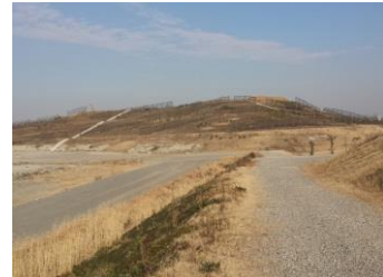
完成に向け、工事が進められています
